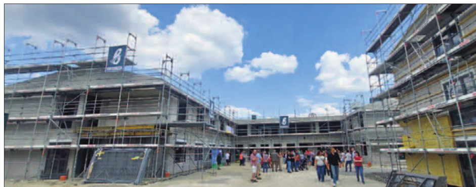
Blick auf den Pflegeheim-Komplex und den künftigen Hof des Quartiers ...
